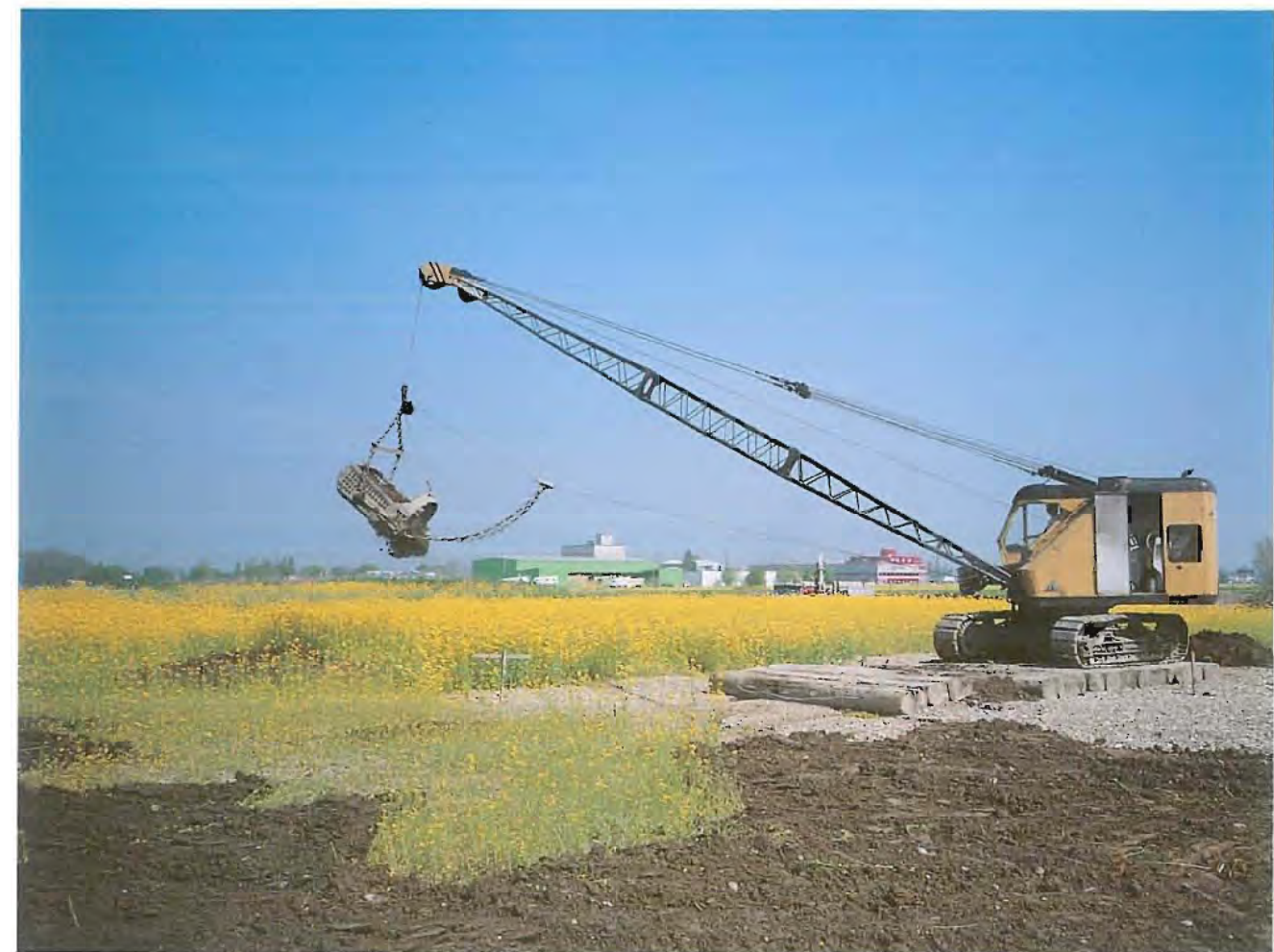
La remise en état d'un sol est une opération complexe et coûteuse. Il faut utiliser des machines adaptées telles qu'une pelle hydraulique, un bouter version LGP ou une pelle à câbles (photo), et procéder à un ensemencement intermédiaire. La remise en culture doit donc ménager le sol.
